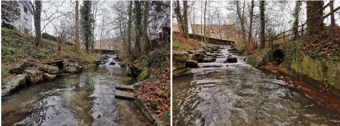
*Abb. 7: Einmündende Überläufe der Siedlungsentwässerung (Blick gegen die Fließrichtung)*
