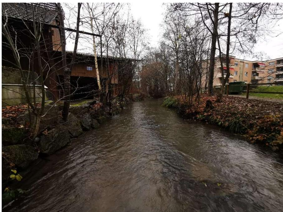
Abb. 4: Ufersicherung beim linksseitigen Bauernhaus (Blick in Fließrichtung)
