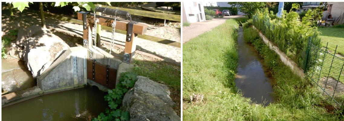
*Abb. 1: Bauwerk zur Ausleitung des Möhlinbachs ins Mühlibächli (links)
