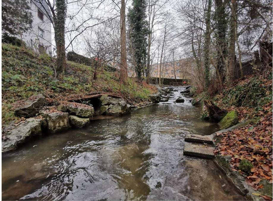
*Abb. 5: Blick von Unterwasser auf die heutige steile Blockrampe und das Schlauchwehr*
