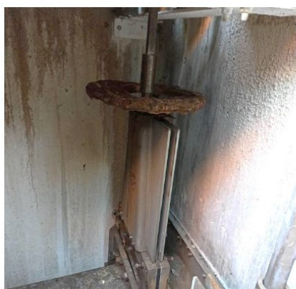
Bild 1: Korrodiertes Handrad
